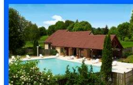
Piscine extérieure chauffée
